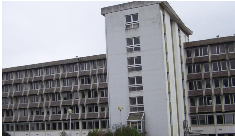
■ L'ancien siège de Manitowok, chemin du Petit-Bois, est réhabilité pour accueillir deux nouvelles écoles. Photo Patrice PESSIA
